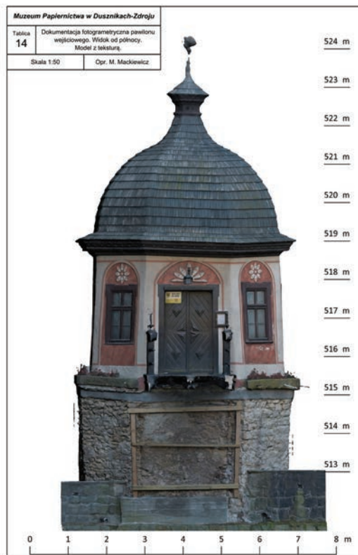
5. Pawilon wejściowy papierni, widok od północy. Przykładowa tablica dokumentacji fotogrametrycznej stanu po skuciu tynków przyziemia. Oprac. M. Mackiewicz
