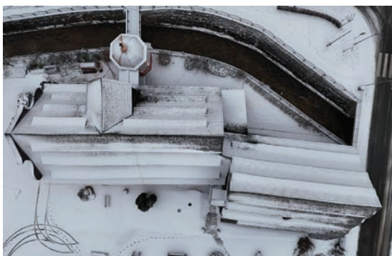
9. Widok z lotu ptaka na elementy zespołu architektonicznego papierni w Dusznikach-Zdroju: młyn papierniczy (usytuowany centralnie), suszarnia (po prawej stronie kadru) oraz pawilon wejściowy (na północ od młyna, bezpośrednio nad rzeką).
