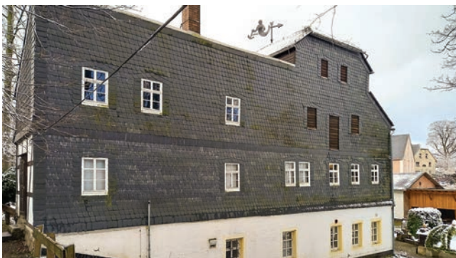
20. Papiernia w Niederzwönitz. Przykład opracowania elewacji poprzez licowanie ich łupkiem na wszystkich kondygnacjach z wyjątkiem przyziemia. Fot. M. Szymczyk
