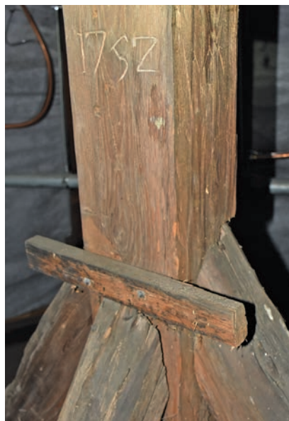
4. Pawilon wejściowy papierni, słup konstrukcji helmu z wyrytą datą 1752.
