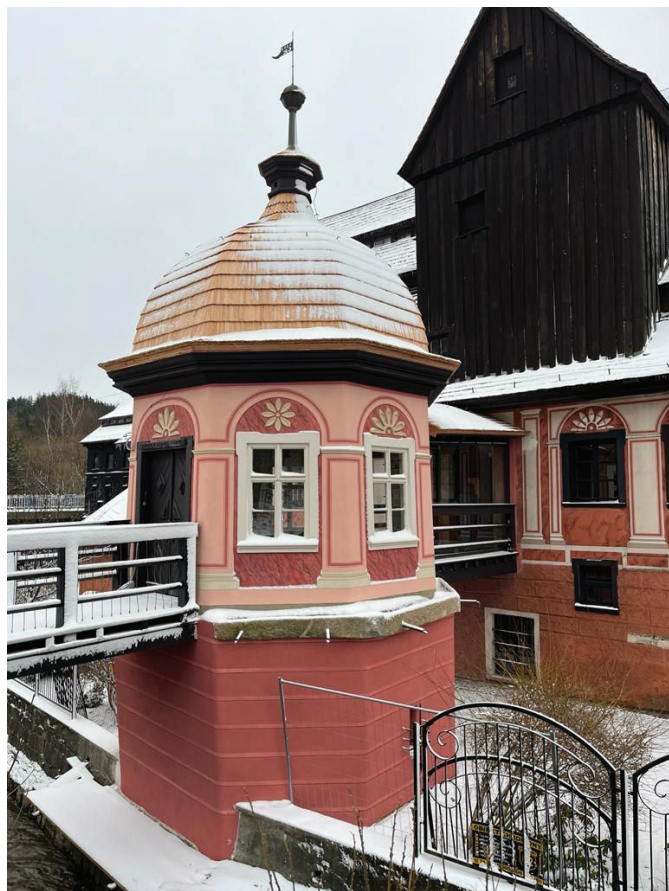
29. Kolorystyka elewacji pawilonu wejściowego po zakończeniu remontu, grudzień 2023.
