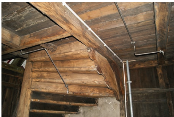
2. Budynek papierni, schody w trakcie północnym. Fot. R. Eysymontt
