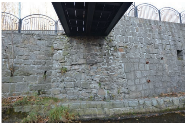
7. Kamienne wzmocnienie koryta rzeki z widocznym filarem mostu, widok od południa. Fot. M. Mackiewicz
