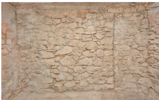
8. Pawilon wejściowy papierni, wewnątrz przyziemia, widok od południa na mur z widocznym stykiem architektonicznym. Fot. M. Mackiewicz
