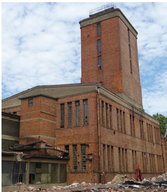
9. Widok na zabudowania fabryczne z wieżą ciśnień w 2020 roku, źródło: Zachodniopomorski Urząd Konserwatora Zabytków, Fot. A. Rychlicka
