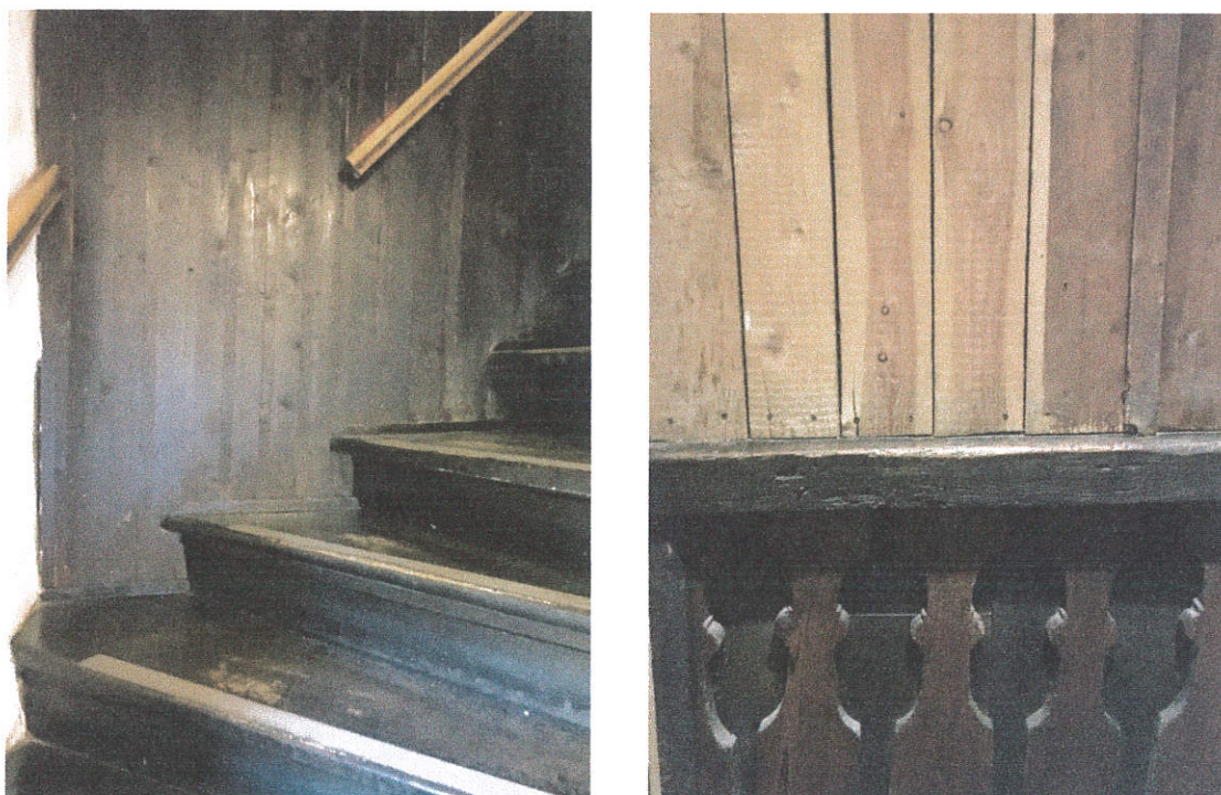
- fragmenty drewnianego różnorodnego obicia klatki schodowej
