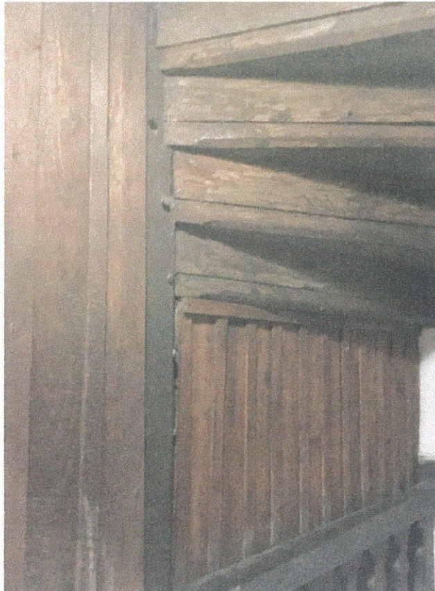
- fragmenty drewnianego różnorodnego obicia klatki schodowej
