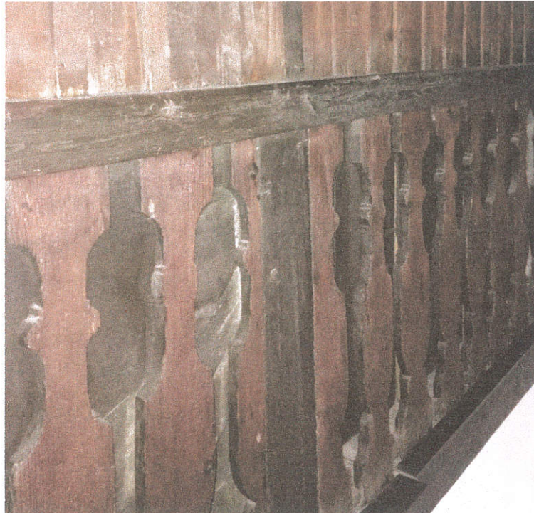
- dekoracyjne płaskie tralki na poziomie I kondygnacji klatki schodowej
