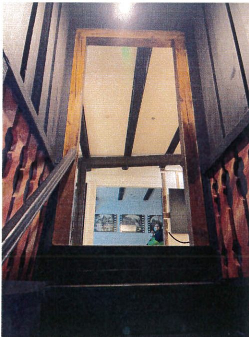
- futryna drzwi i kondygnacji schodów dla której proponuje się odtworzenie opaski drzwiowej,
