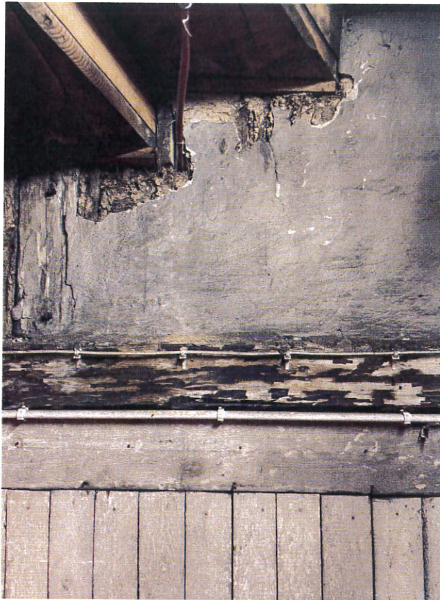
- widok na ścianę szachulcową II kondygnacji schodów
