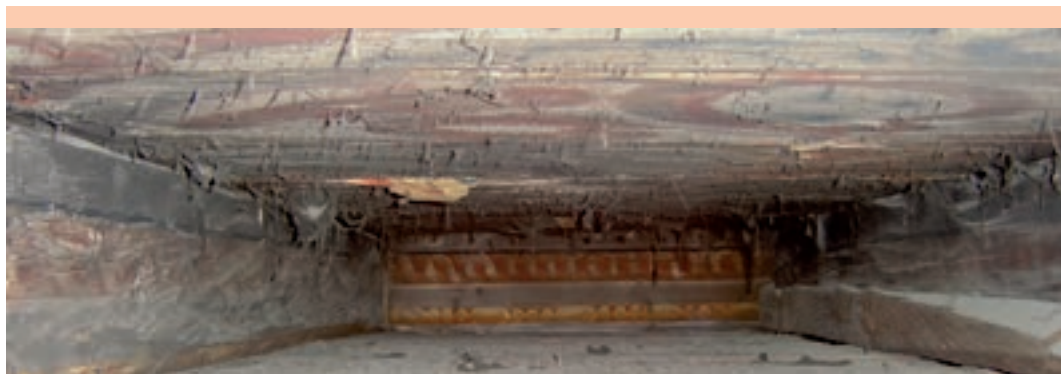
Fragment pierwotnego sufitu polichromowanego, zakrytego przez późniejszy strop „Sali pod kopułą”
