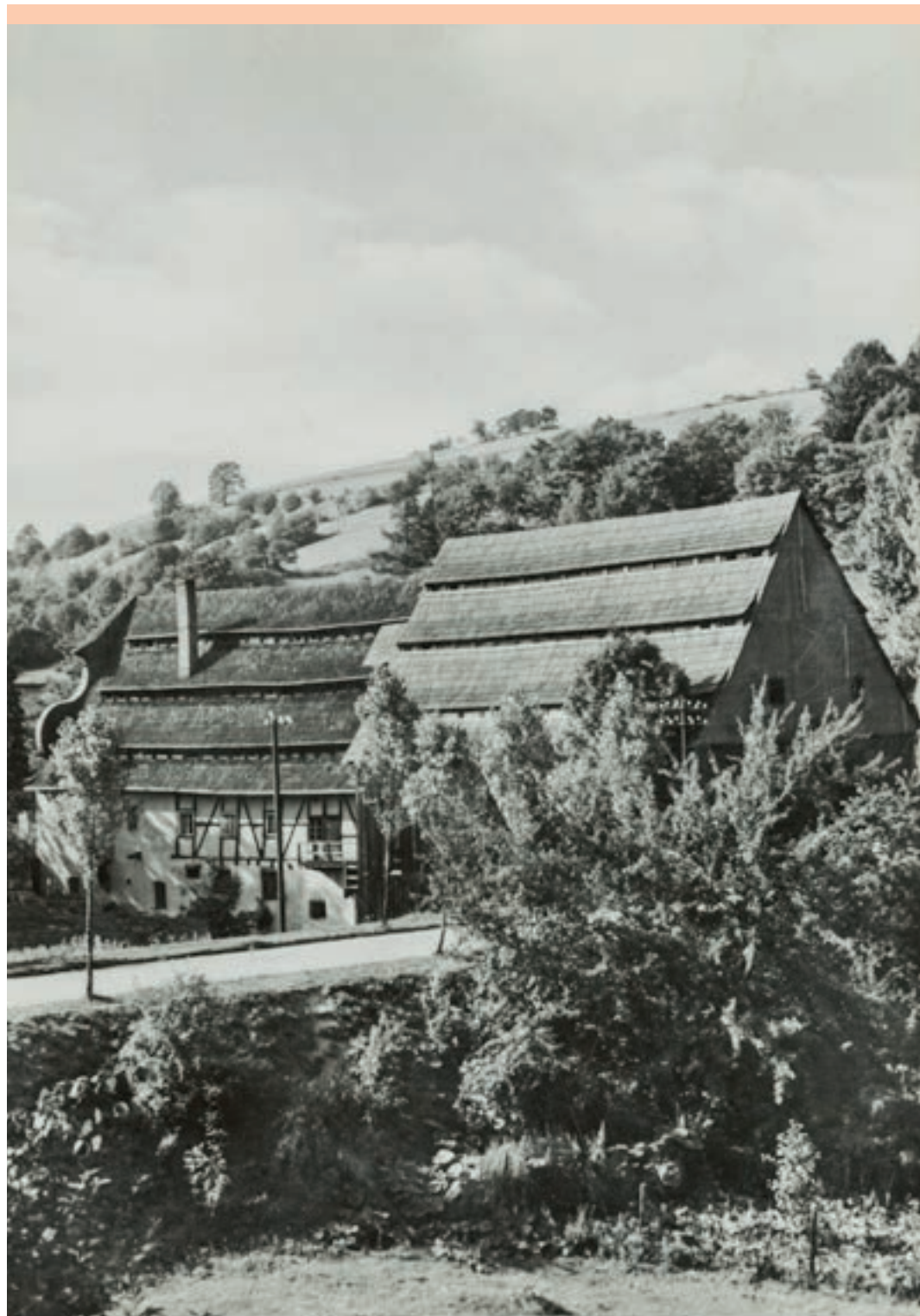
Widok od strony południowo-wschodniej, lata 60. XX w.
