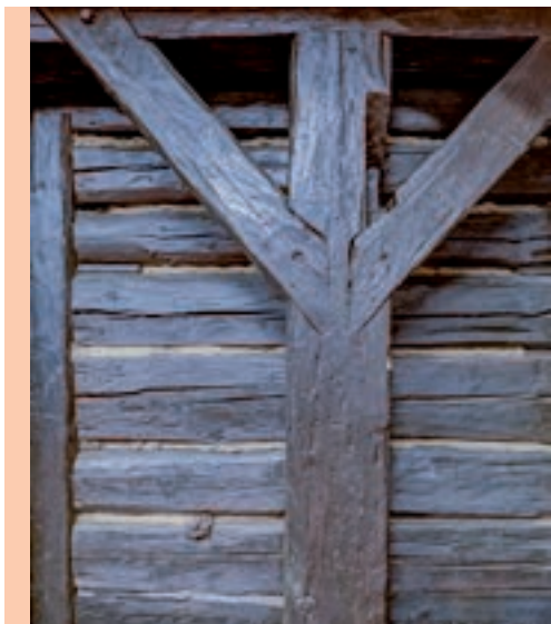
Ściana wieńcowa wewnątrz suszarni, wzniesiona z belek pozyskanych na przełomie XVI i XVII w.
