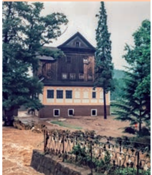
Powódź, stan wody rankiem 23.07.1998 r.
