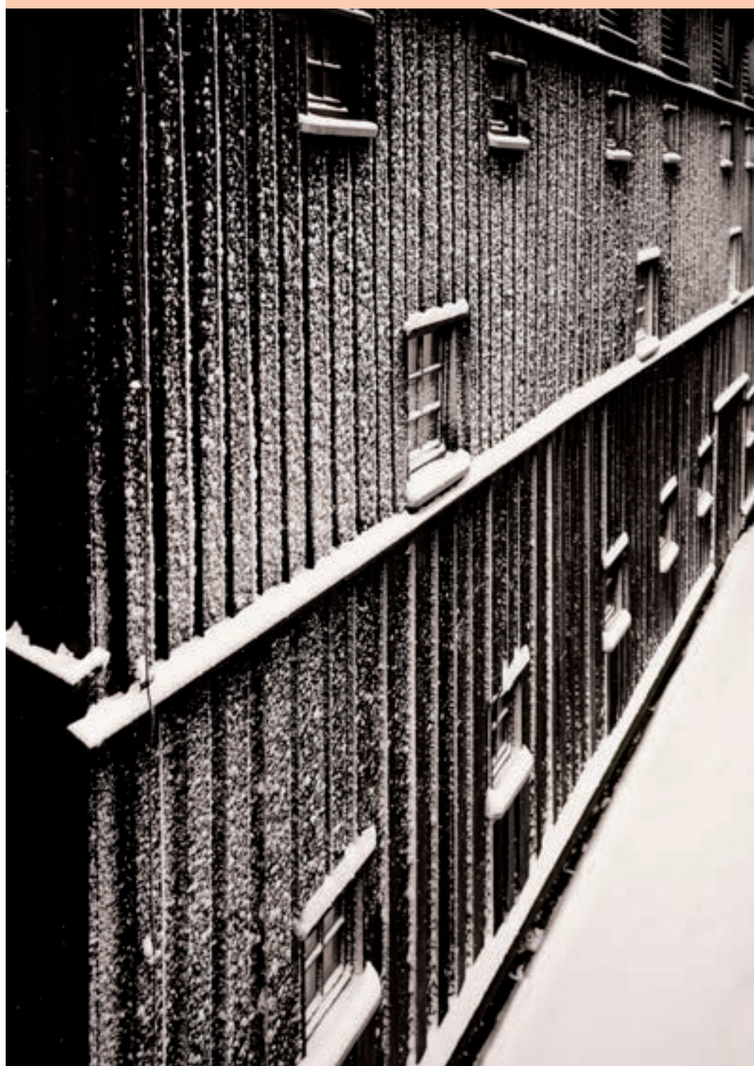
Północno-wschodnia elewacja suszarni
