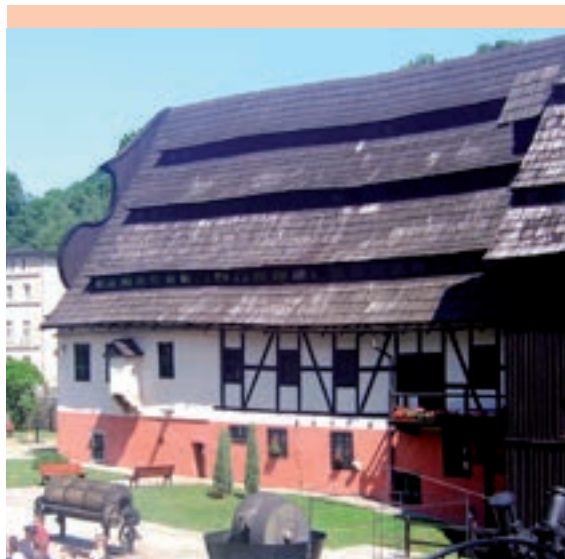
Południowa ściana szachulcowa
