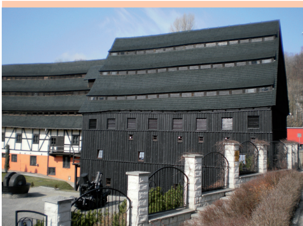
Budynek suszarni od strony południowej
