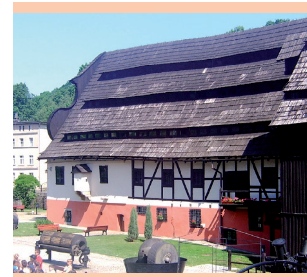
Południowa ściana szachulcowa
