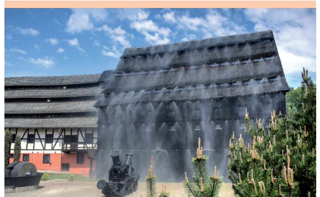
Oddanie do eksploatacji systemu gaszenia mgłą, 2017 r.
