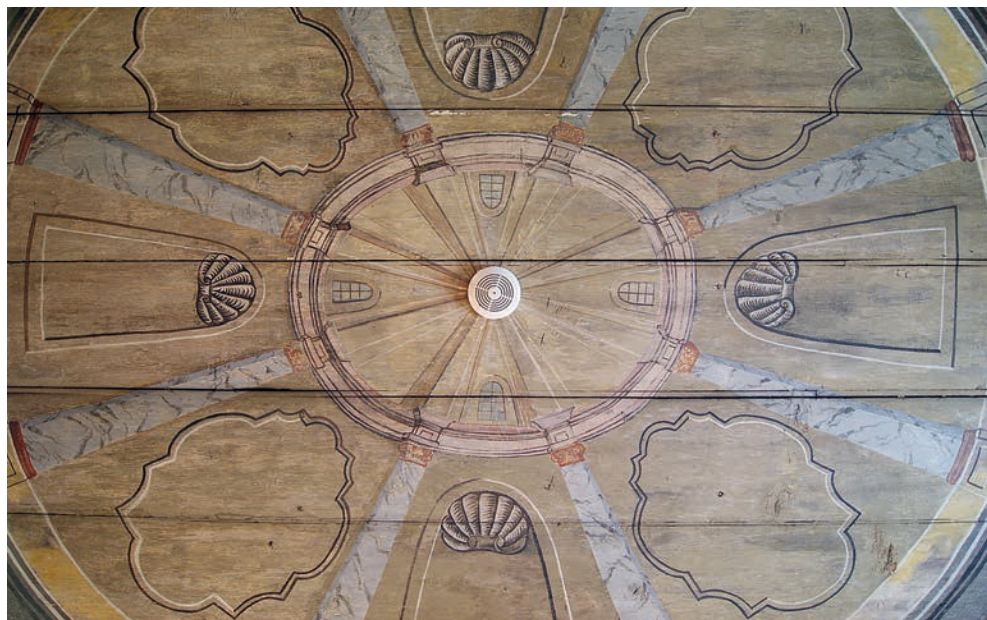
11. Iluzjonistyczna kopuła, strop w Sali pod Kopułą drugiej kondygnacji, Duszniki-Zdrój, młyn papierniczy, lata 70. XVIII wieku. Fot. Adam Szeląg, 2016.
