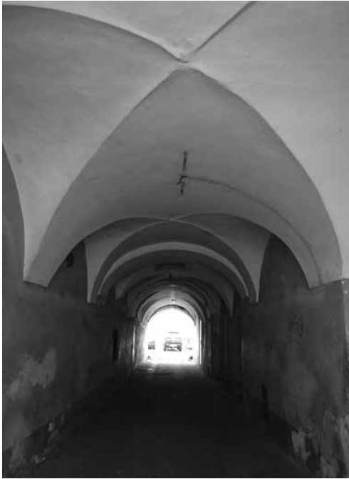
Sień przejazdowa domu przy ul. Słowackiego 2. Fot. K. Dackiewicz
