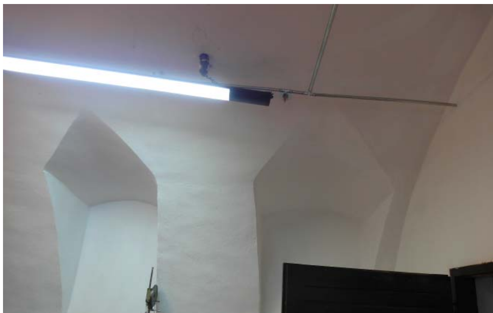
10. Lunety z ostro zarysowanymi krawędziami w przyziemiu młyna (fot. Rafał Eysymontt, 2016)
